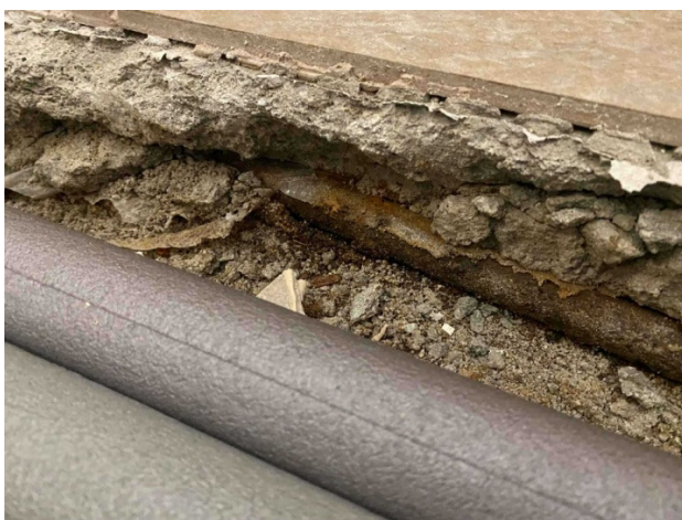
Umístění potrubí podpodlahových rozvodů ÚT (páteční rozvod a podružný rozvod k otopným tělesům v koupelnách), na pravém obrázku je v přední partii již nové Cu potrubí provedené v rámci předpokládané opravy a náhrady původního ocelového.
