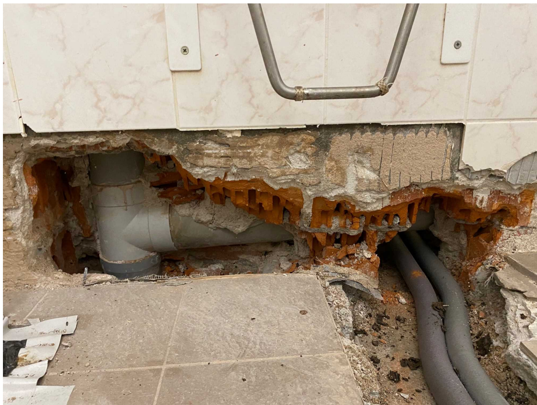
Stoupačka kanalizace s vodorovným napojením WC mezi koupelnami a lepené spoje PVC potrubí.
