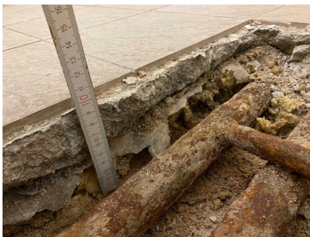
Umístění potrubí podpodlahových rozvodů ÚT (páteční rozvod a podružný rozvod k otopným tělesům v koupelnách), na pravém obrázku je v přední partii již nové Cu potrubí provedené v rámci předpokládané opravy a náhrady původního ocelového.
